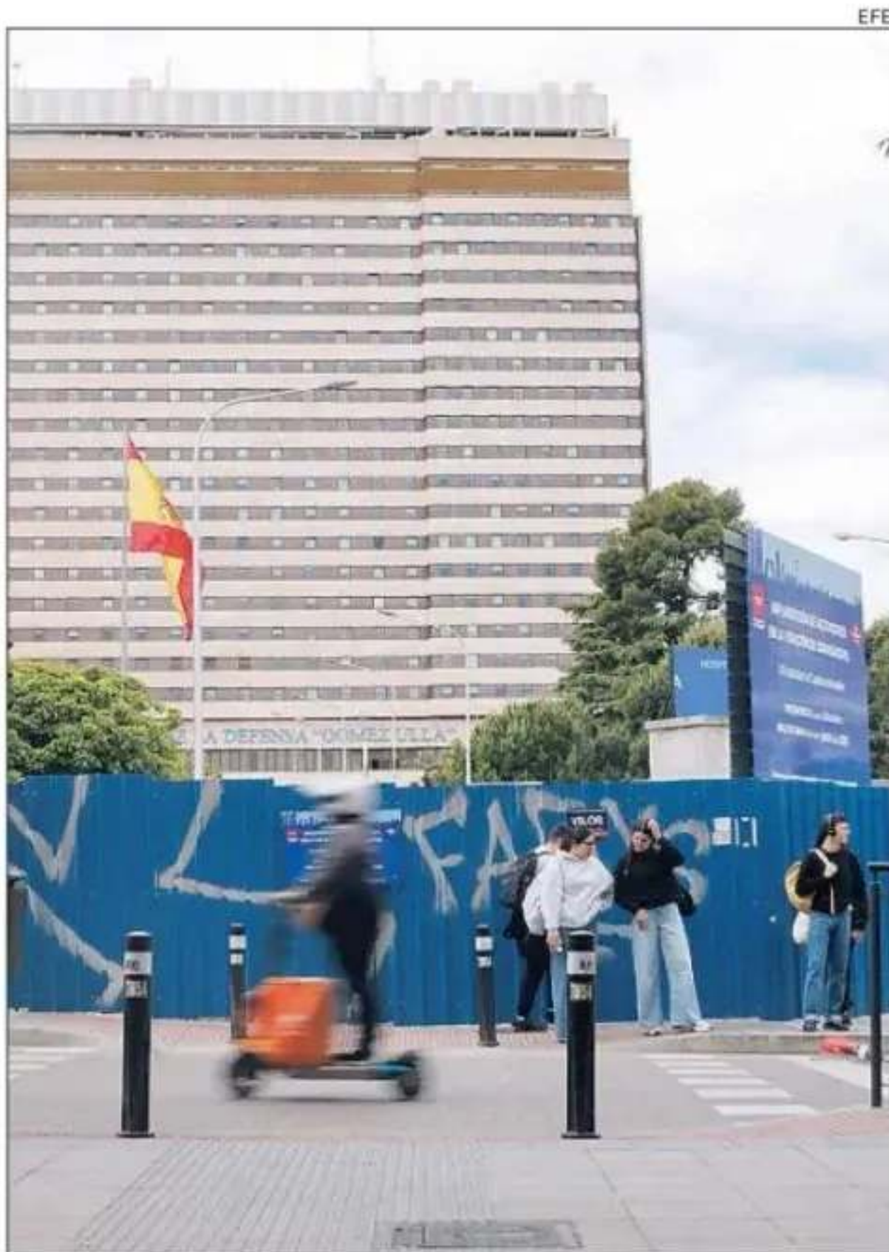
Vista exterior de la Unidad de Aislamiento en el Gómez Ulla
